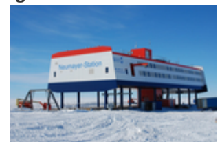
Neumayer-Station III mit Schiebekran
