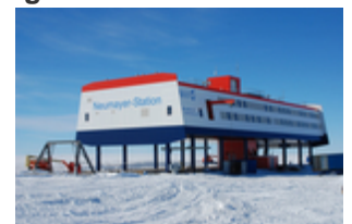
Neumayer-Station III mit Schiebekran
