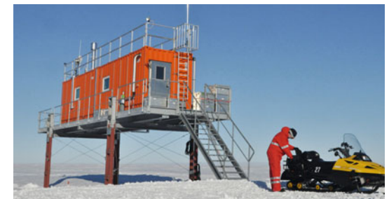
▲ Einen Kilometer südlich der Neumayer-Station III steht das neue Spurenstoffobservatorium. (Foto: U. Cieluch)
